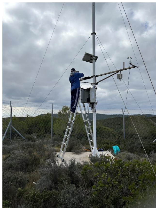
Εικόνα 1.2-2: Απο τις τεχνικές εργασίες αντικατάστασης ανεμόμετρου στον σταθμό ΖΚΤ-1.
