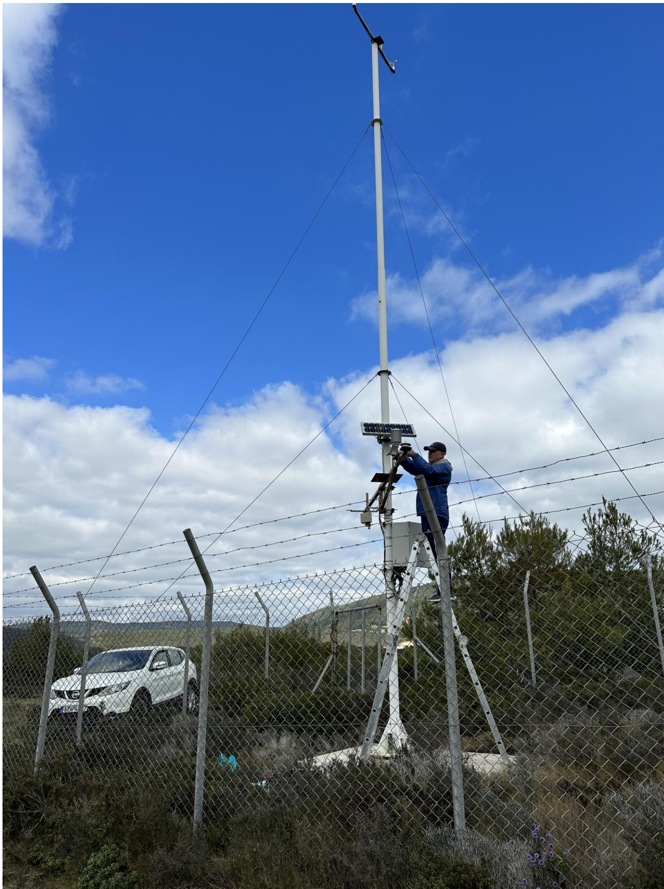
Εικόνα 1.2-3: Απο τις τεχνικές εργασίες στον σταθμό ΖΚΤ-1 στις 19/2/2023.
